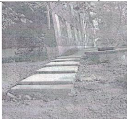
Фото 7. Лестница на пути к объекту.
