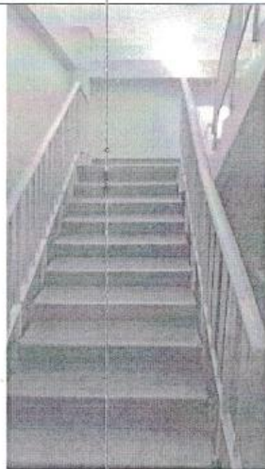
фото 16 лестница на второй этаж
