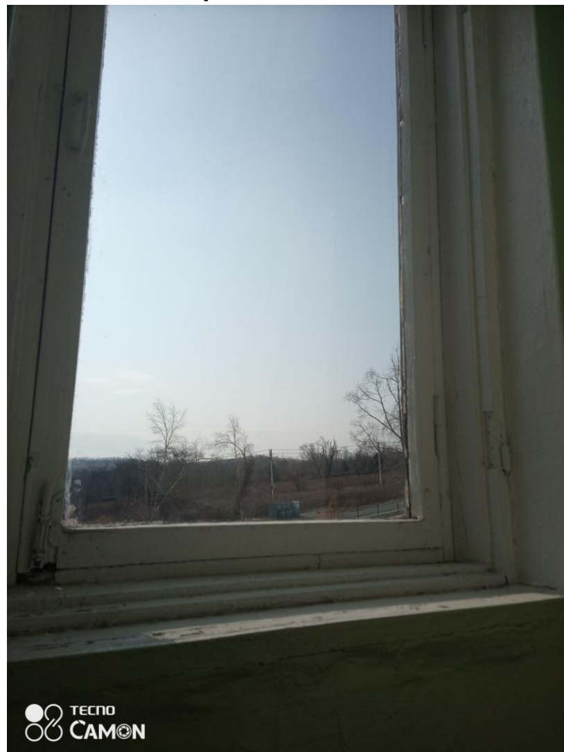
окна в актовом зале после ремонта
