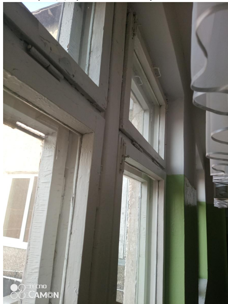
коридоры после ремонта
