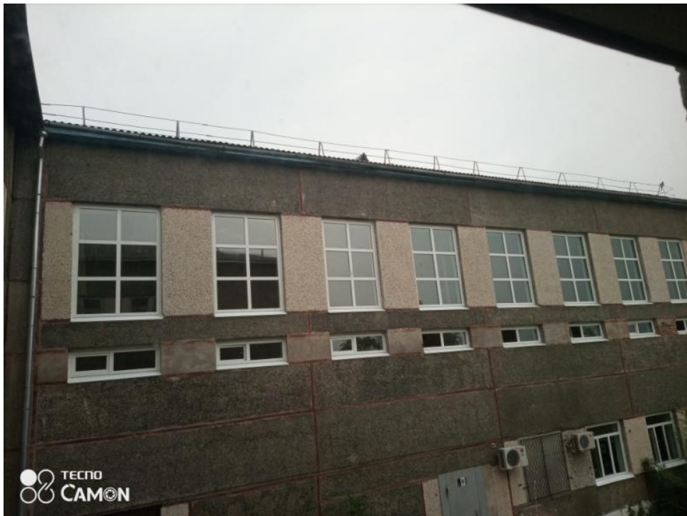
окна в актовом зале до ремонта
