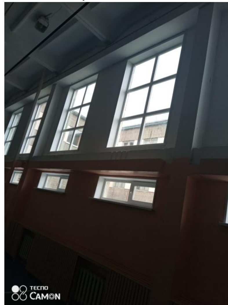
окна спортивного зала после ремонта
